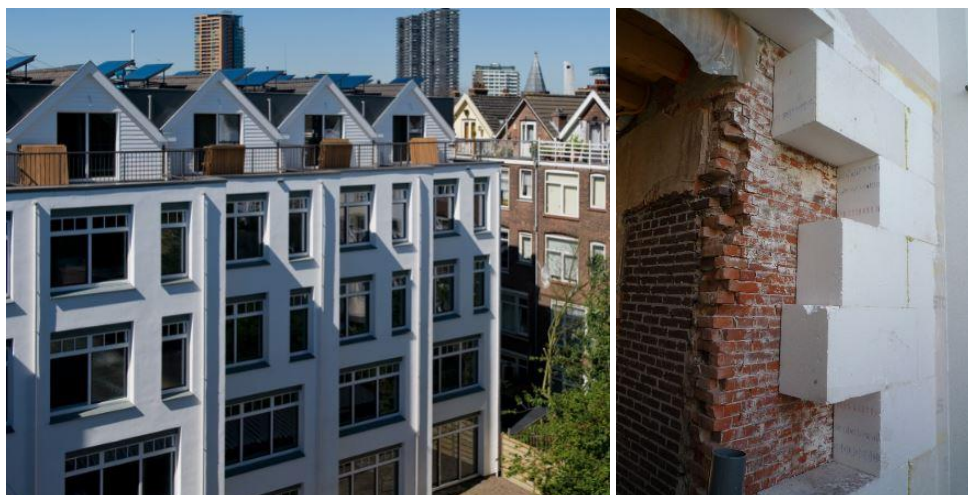
Rénovation d'un complexe résidentiel à Rotterdam, aux Pays-Bas.
