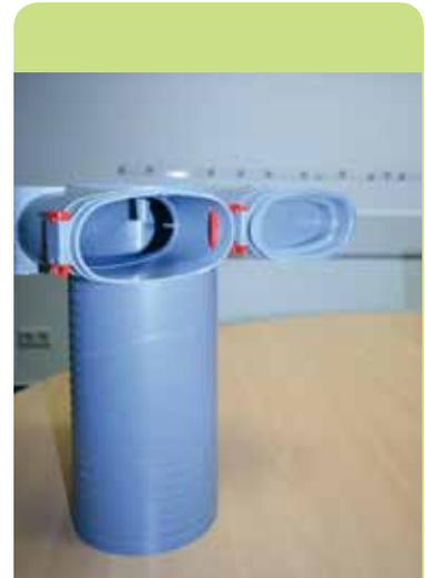
Das Verschließen der Rohr-Enden z.B. mit Kunststoffolie während der Bauarbeiten führt zu sauberen Kanälen für den Transport von Frischluft. Die Hersteller bieten oft Abdeckungen an, um die Qualitätsarbeit schnell und einfach zu machen.
