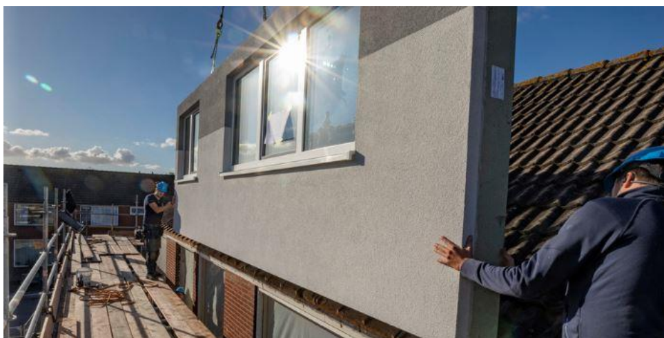
Serielle Sanierung von 194 Reihenhäusern in der Provinz Zeeland, Niederlande, mit vorgefertigten Elementen. Das spart Bauzeit und Baukosten. © Bouwbedrijf Joziassse
