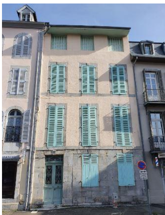
Sanierung dringend nötig: Mehrfamilienhaus in Bagnères de Bigorre in den französischen Pyrenäen. © F. Colas
