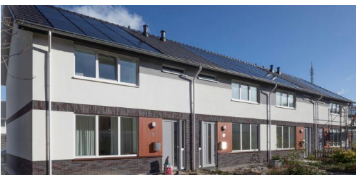
Die 194 Reihenhäuser nach der seriellen Sanierung, inklusive Photovoltaik-Anlage. Die Bewohner konnten während der Bauarbeiten in ihren Häusern wohnen bleiben. © Bouwbedrijf Joziassse
