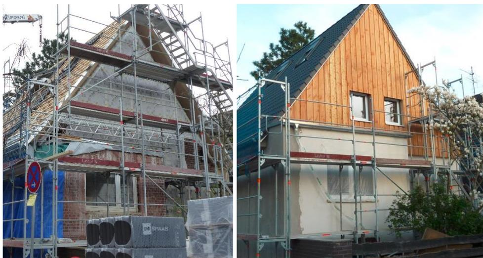
Vom Keller bis zum Dach wird dieses Einfamilienhaus in Darmstadt aktuell mit Passivhaus-Komponenten saniert. Der Charme des Gebäudes bleibt dabei erhalten. Bild links: Stand der Arbeiten Ende 2023; Bild rechts: Sommeranfang 2024. © Passivhaus Institut
