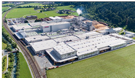
FRITZ EGGER GmbH & Co. OG Holzwerkstoffe wood processing plant in St. Johann in Tyrol; https://www.egger.com/shop/de_AT/ueberuns/oesterreich ; © FRITZ EGGER GmbH
